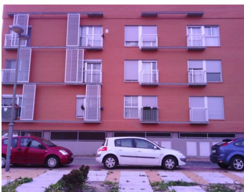
OBRA 2 Móstoles (Madrid). Fachada AUTOPORTANTE de ladrillo cara vista. AUSENCIA de puentes térmicos en los frentes del forjado.
