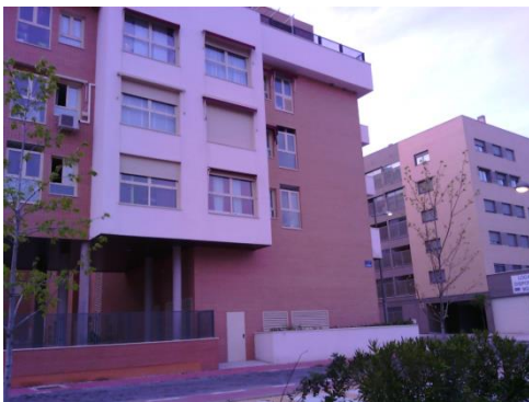
OBRA 1 Móstoles (Madrid). Fachada CONFINADA de ladrillo cara vista. PRESENCIA de puentes térmicos en los frentes del forjado.
