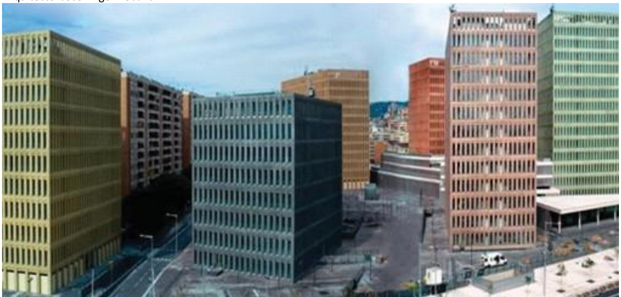
Ciudad de la Justicia (Barcelona - Hospitalet de Llobregat) Arquitectos: David Chipperfield – Fermín Vázquez B720
